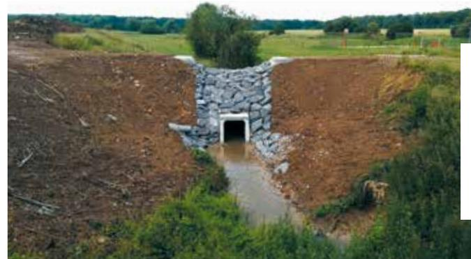
Travaux réalisés en amont de Chesny pour protéger le bassin versant du ruisseau Saint-Pierre des inondations. Le but est de réduire le débit maximal pour répartir le volume de la crue dans le temps.
