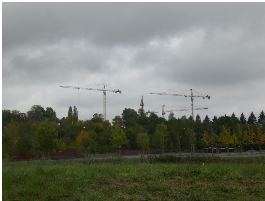
Destructions de toutes les constructions légères mises en place par les Canadiens, site mis à nu pour pouvoir commencer les travaux.
