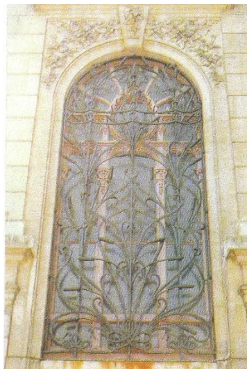
Vue extérieure de la verrière Modern Style, roseaux en fer forgé Source de toutes les photos de cette partie : site internet mairie d'Ars-Laquenexv
