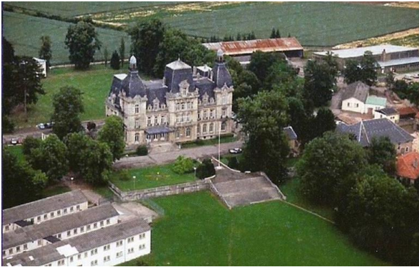
Vue aérienne sur le château
